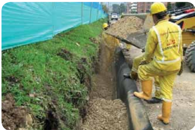
Avenida 9 Calle 127 - Bogotá, 2008 Geodrén Vial 100 mm / 1 mt
