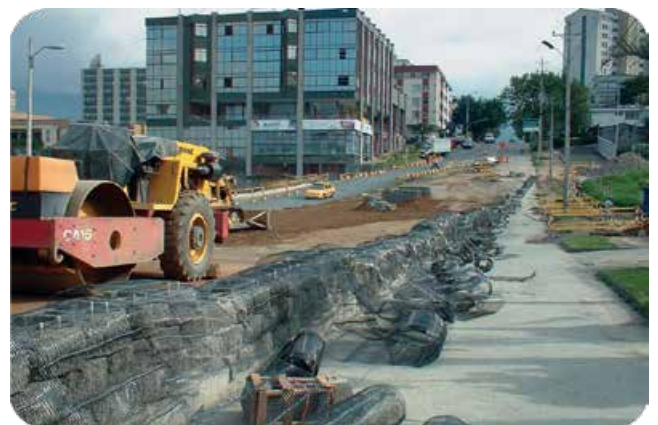
Puente Calle 14 - Pereira, 2003 (TT050 - TT070)
