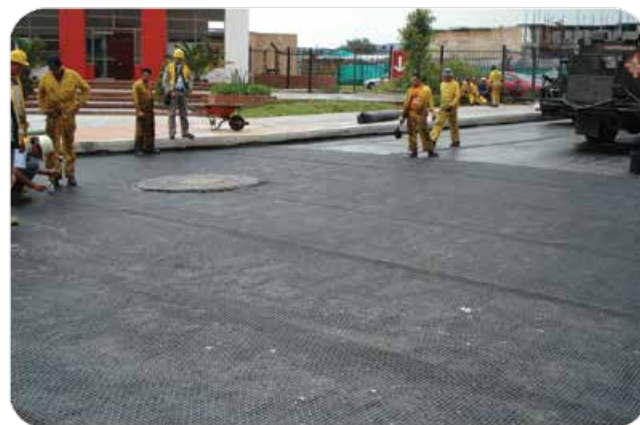
Intersección Cra. 53A - Calle 127 - Bogotá, 2008 (R 100)
