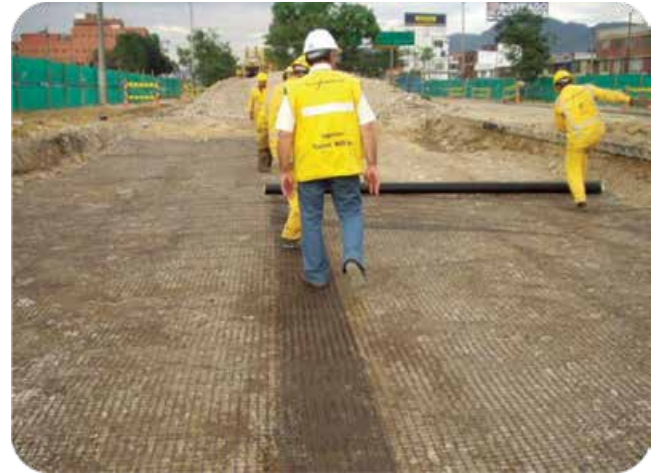
Troncal Transporte Masivo NQS Sur Tramo 1 Bogotá, 2005 (LBO 202)
