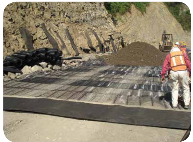
Nuevo Necaxa - Tihuatlán, Edo. de Puebla, 2011 (TT090, TT070, Geotextil T2400)
