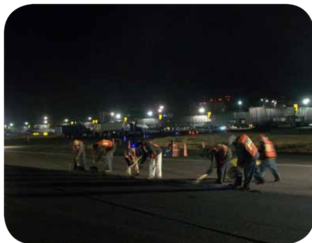
Aeropuerto Internacional Benito Juárez, México, D.F., 2010 Geotextil No Tejido de repavimentación
