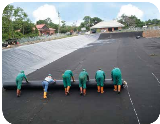
Relleno Sanitario Paz de Ariporo Casanare, 2004 (NT 2000)
