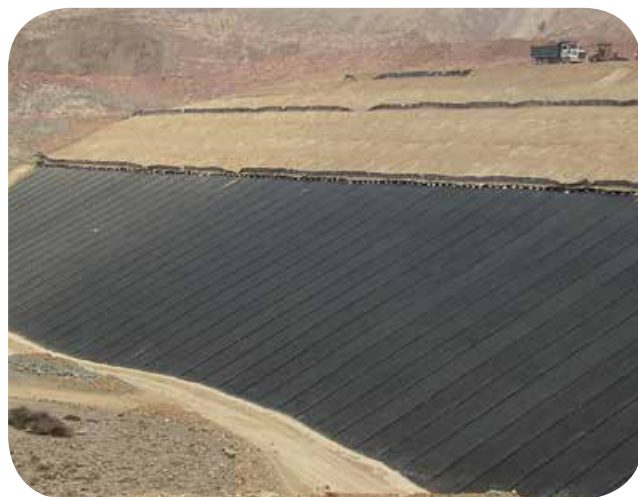
Cerro Verde - Perú, 2005 Geotextil 8250 m
