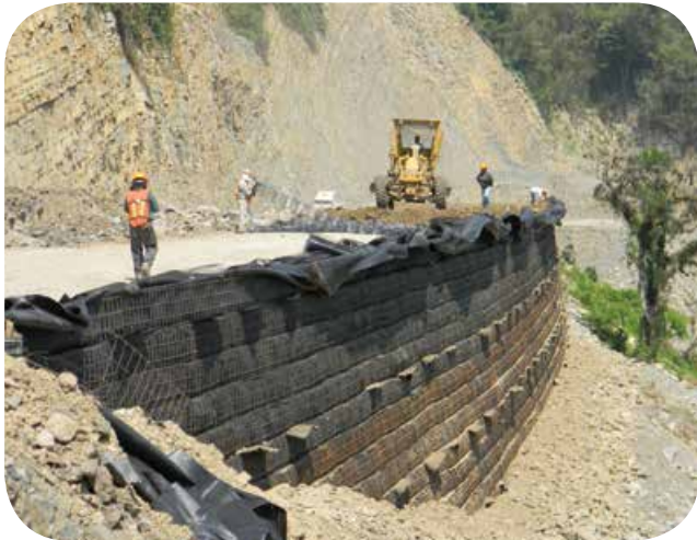
Muro en Suelo Reforzado Nuevo Necaxa- Tihuatlán, Edo de Puebla, México 2011
