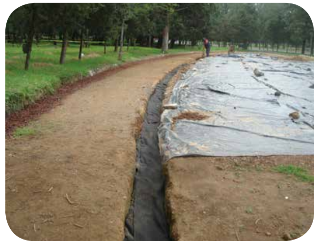
Ágora Fuente Tláloc, Chapultepec, México, D.F., 2010 Sistema de Subdrenaje con Geotextil NT2500
